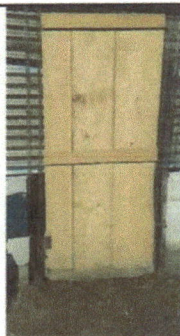
Foto 5: Fotografía de puerta con necesidad de cambio ya que actualmente no brinda ninguna seguridad al establecimiento.
